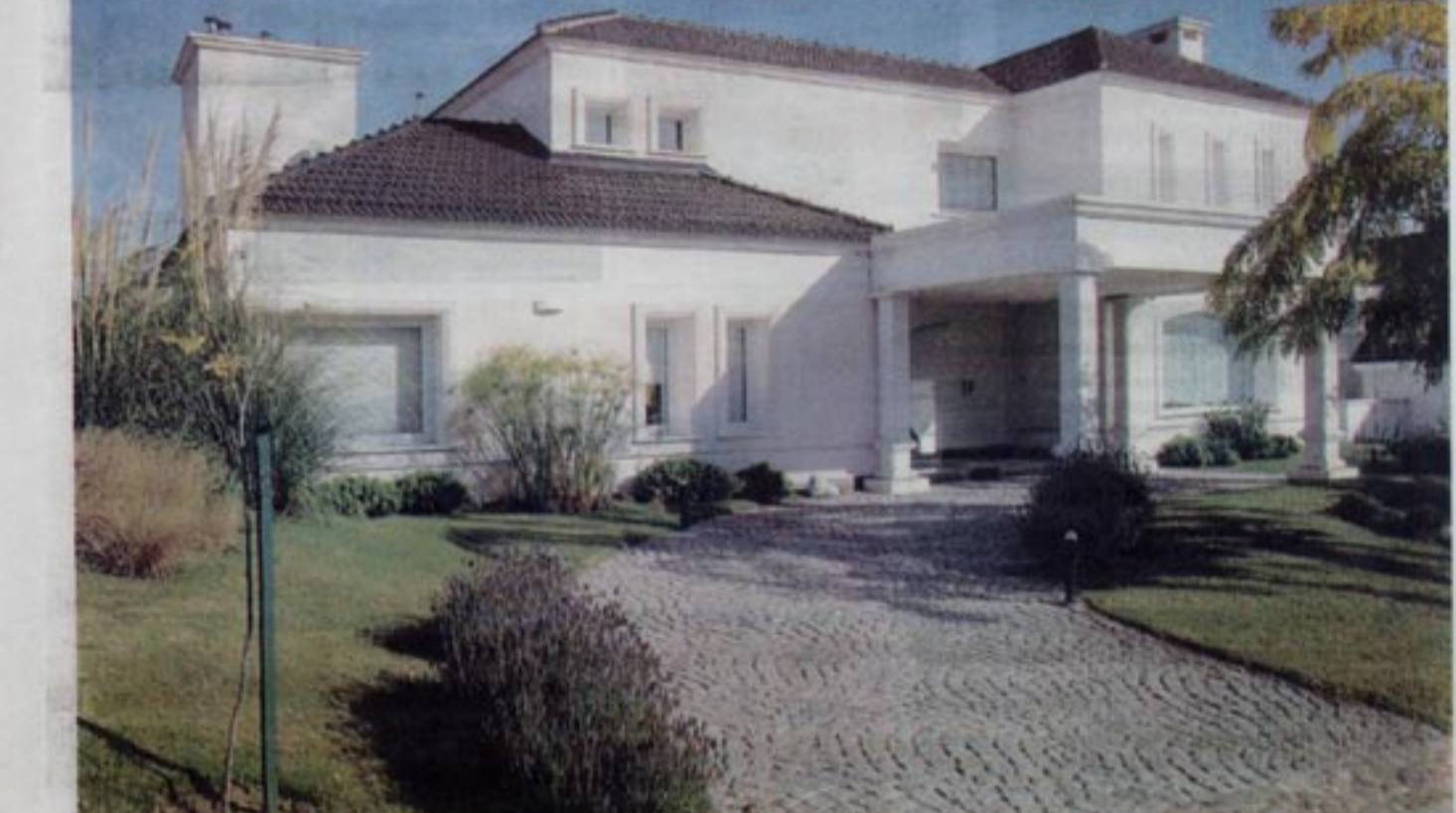
PARTIDO 1 El partido responde a un esquema en forma de "L", en planta, y se organiza entorno al núcleo de circulación vertical formado por escalera.
